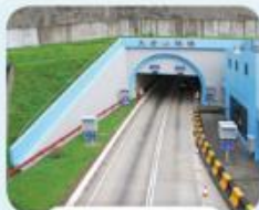
B. 興建隧道
